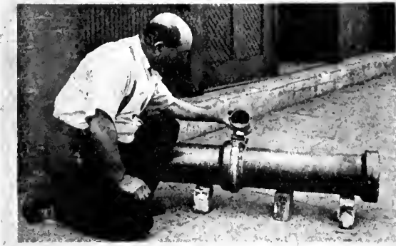
Pouring the Joint.
